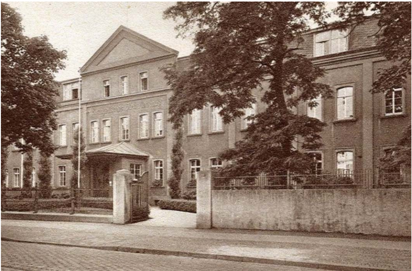
Das Haus A des Evangelischen Krankenhauses Oberhausen (EKO). Der ehemalige Haupteingang von der Virchowstraße
