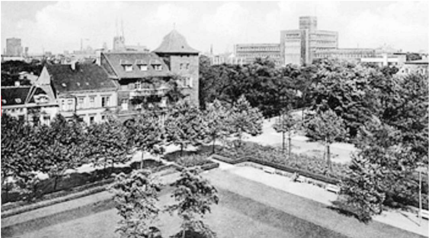
Das neue Rathaus (rechts), das Sparkassengebäude (mitte), die Türme der Marienkirche, der Wasserturm an der Mülheimer Straße (links) und der Hochgasscheibenbehälter.
